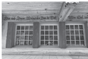
umbau haus in trueb
