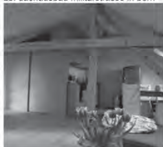
zb. dachausbau militärstrasse in bern
